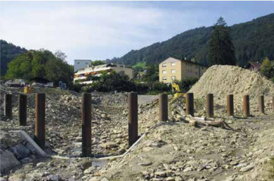
Geschiebe- und Treibholzfang während der Bauarbeiten; an den Stahlsäulen bleibt das Holz hängen und dahinter staut sich das Geschiebe auf.
