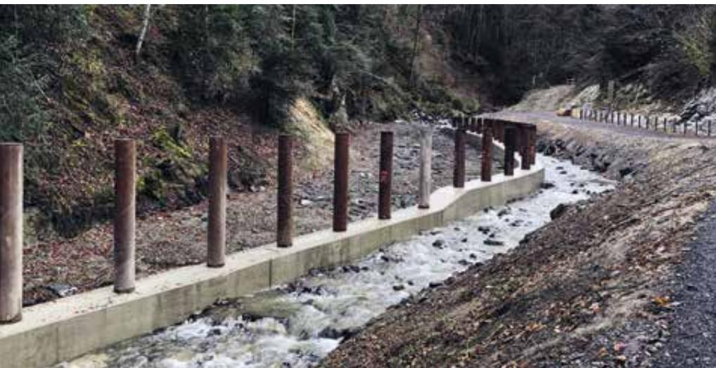
Betonriegel mit «Metallrechen». Links der Holzurückhalt, rechts der Bachlauf bei Niederwasser.
