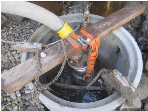
Abbildung 3-5: Beispiel Wasserhaltung mit oberflächennahem Pumpensumpf, eingelegt in Filterschicht
