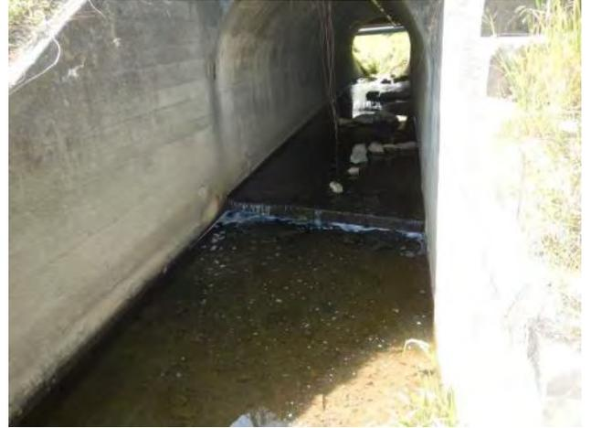
Mündungsbereich Ächeli-Binnenkanal: der bei Niederwasser dünn überströmte Absturz im SBB-Durchlass ist für verschiedene Fischarten vermutlich nur dann fischgängig, wenn bei Hochwasser der ganze Durchlass eingestaut wird.
